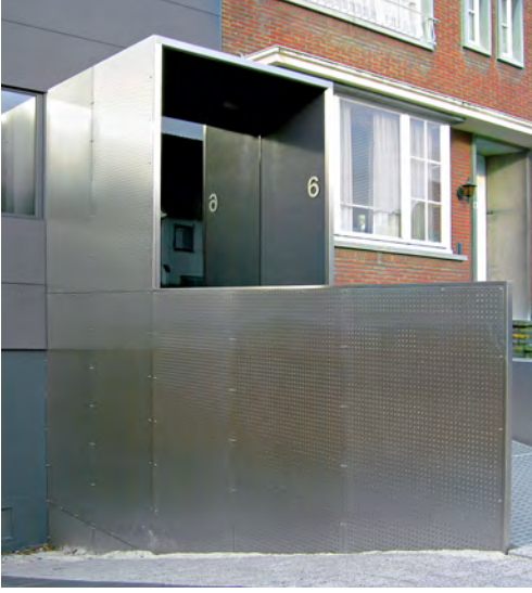
Bina girişindeki antre inşaat, mahallinde ustalarla beraber çizilerek planlanmıştır.
